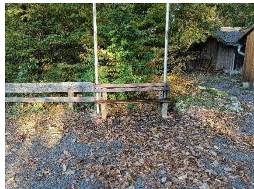
Die Bank am Vorplatz wurde erneuert.
